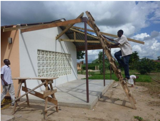
Das Dach des Carports musste vorübergehend abgenommen werden.
