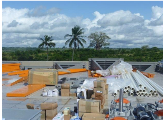
...um das Material auf das Flachdach der Schule zu bringen.
