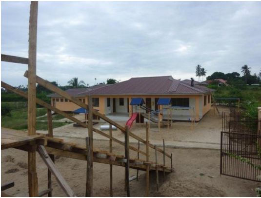
Eine provisorische Rampe wurde erstellt.....
