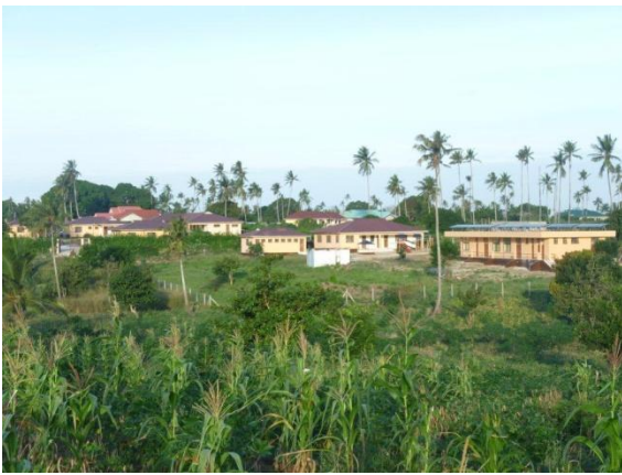
Fernsicht auf das TW Gelände
