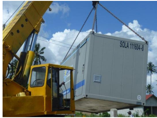
Ein spezieller Kran hob den Container vom Lastwagen...
