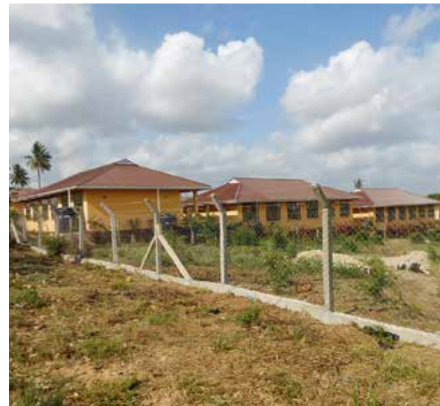
Das Nachbargrundstück konnte im Mai 2013 gekauft werden. Längerfristig werden hier acht zusätzliche Klassenzimmer gebaut.
