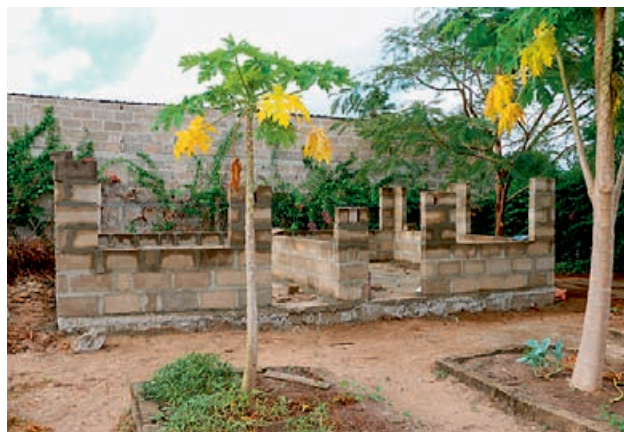
Mit dem Bau des Hühnerhauses geht es schnell vorwärts.
